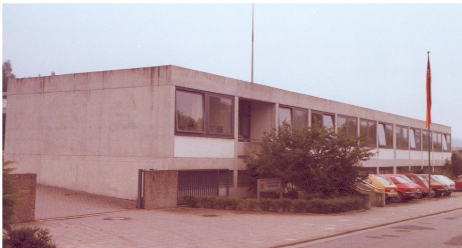
Das Eichamt Kaiserslautern in der Pariser Straße 289
