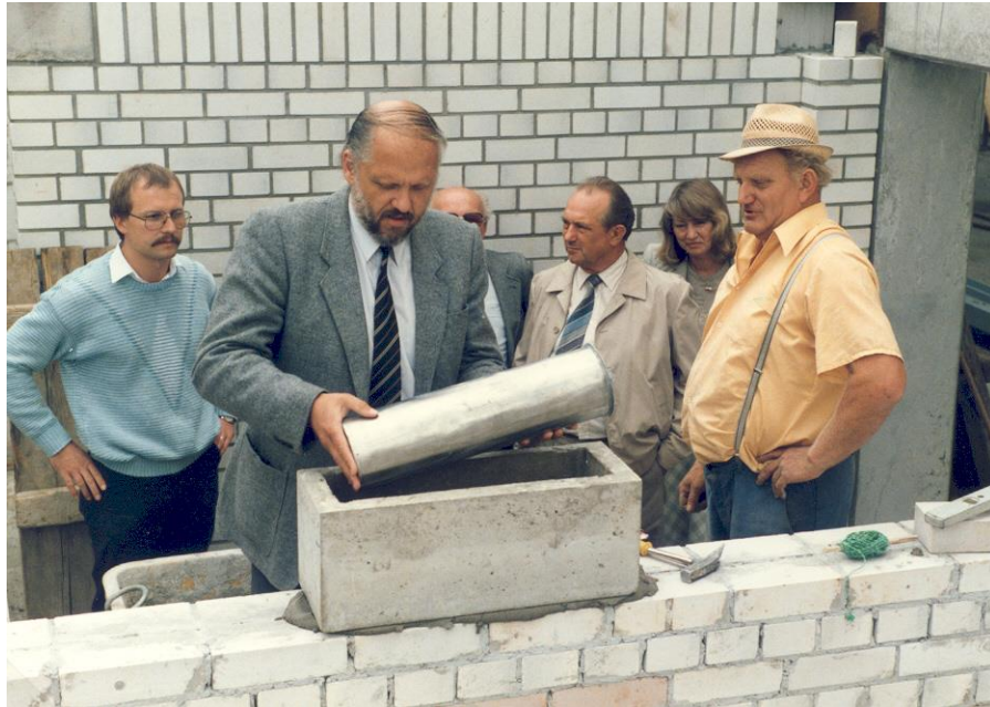
Herr Gögge legt den Edelstahlbehälter in die vorbereitete Wanne in der Mauer
